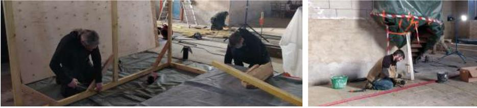
L'entreprise **SORENOV**, en charge de la maçonnerie et de la taille de pierre, a terminé les travaux prévus en périphérie comme la dépose des lambris, la réalisation des caniveaux permettant entre autres le passage de câbles électriques. Elle achève actuellement le rejointement au mortier de chaux naturelle du dallage schiste. Parallèlement, un encoffrement du mobilier religieux a été réalisé pour le protéger pendant toute la durée des travaux. Les entreprises de plâtrerie et de charpenterie
