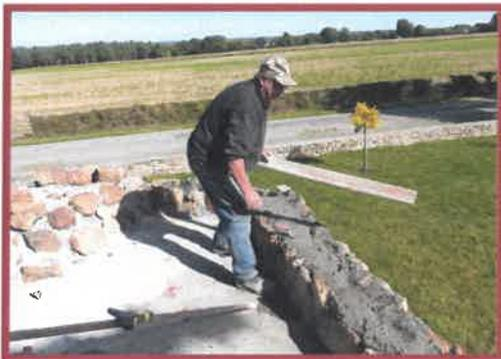
*Autre chantier de cette année : les maçons ont remodelé l'arrière de la grotte avec des pierres rouges rondes, et mis en place un escalier en pierre de schiste.*
